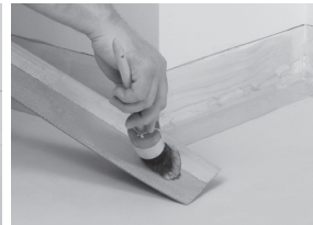
Appliquer la colle sur le sol et contre le mur jusqu'à la ligne.
