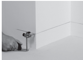
Marquer d'une ligne la hauteur du revêtement contre le mur...
